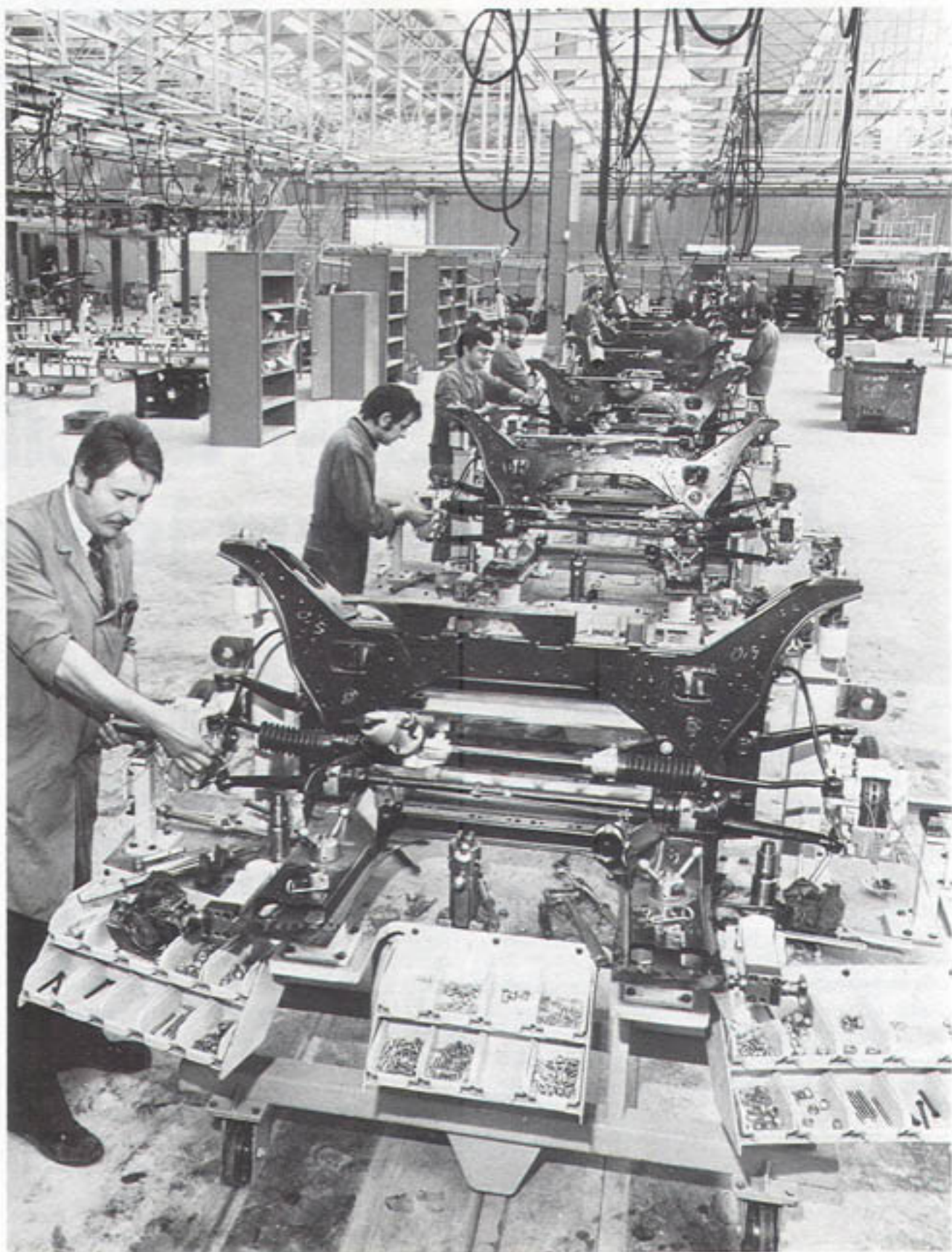
Le montage du train avant à Caen.
