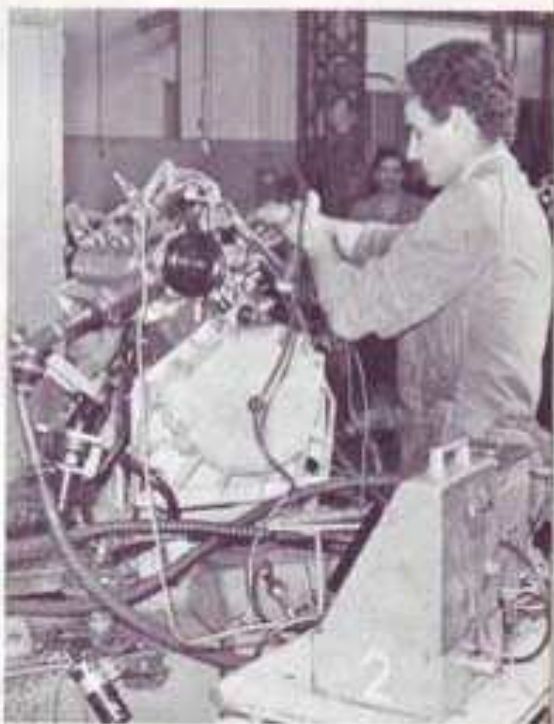
Ensemble moteur-boîte de vitesses-transmission de la CX
