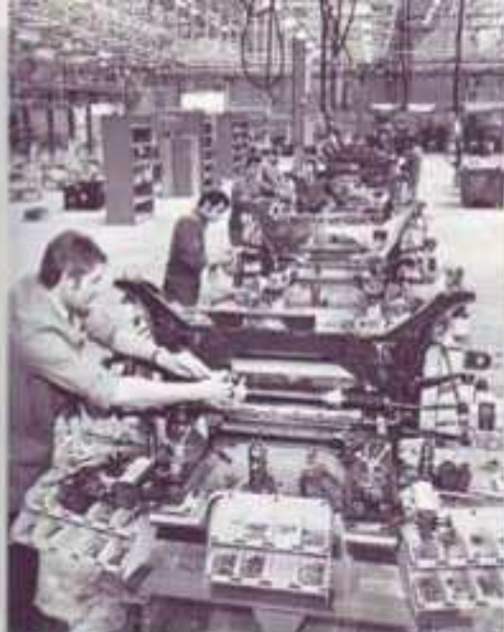
◀ Le montage des essieux avant.
