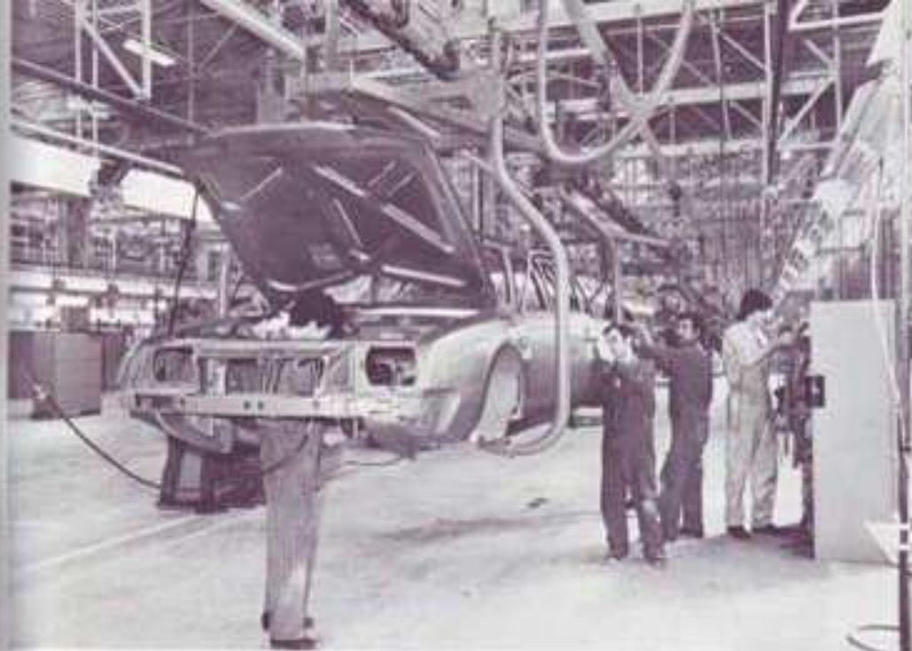
La balancelle-crabe, suspendue au convoyeur tri-rail, laisse la plus grande liberté de manœuvre au personnel : le départ de la première finition.
